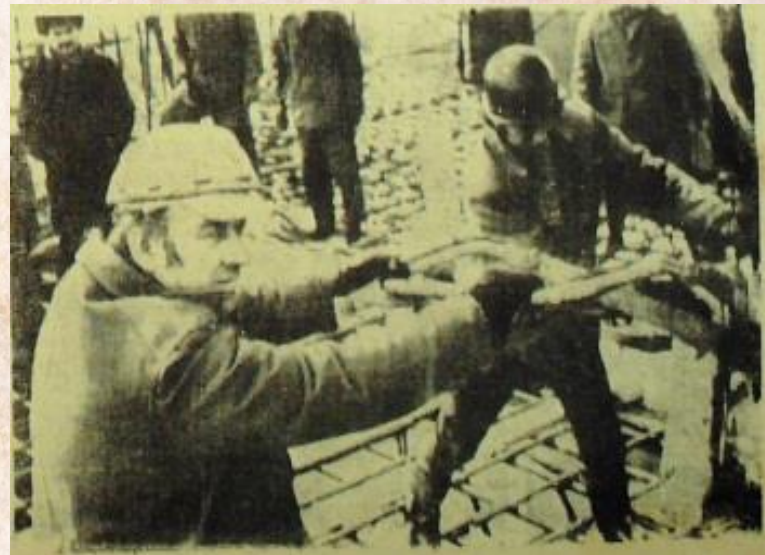
Бригадир комплексной механизированной бригады машинист-эксковаторщик А.В. Осокин открывает задвижку ковша с первым бетоном
