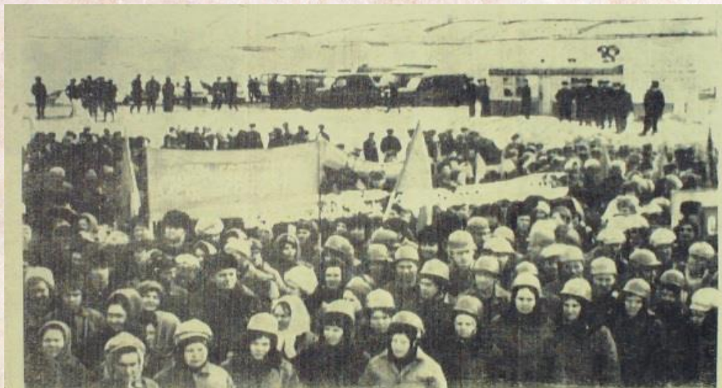
Митинг гидростроителей , посвящённый укладке первого куба бетона в основании камеры шлюза.
