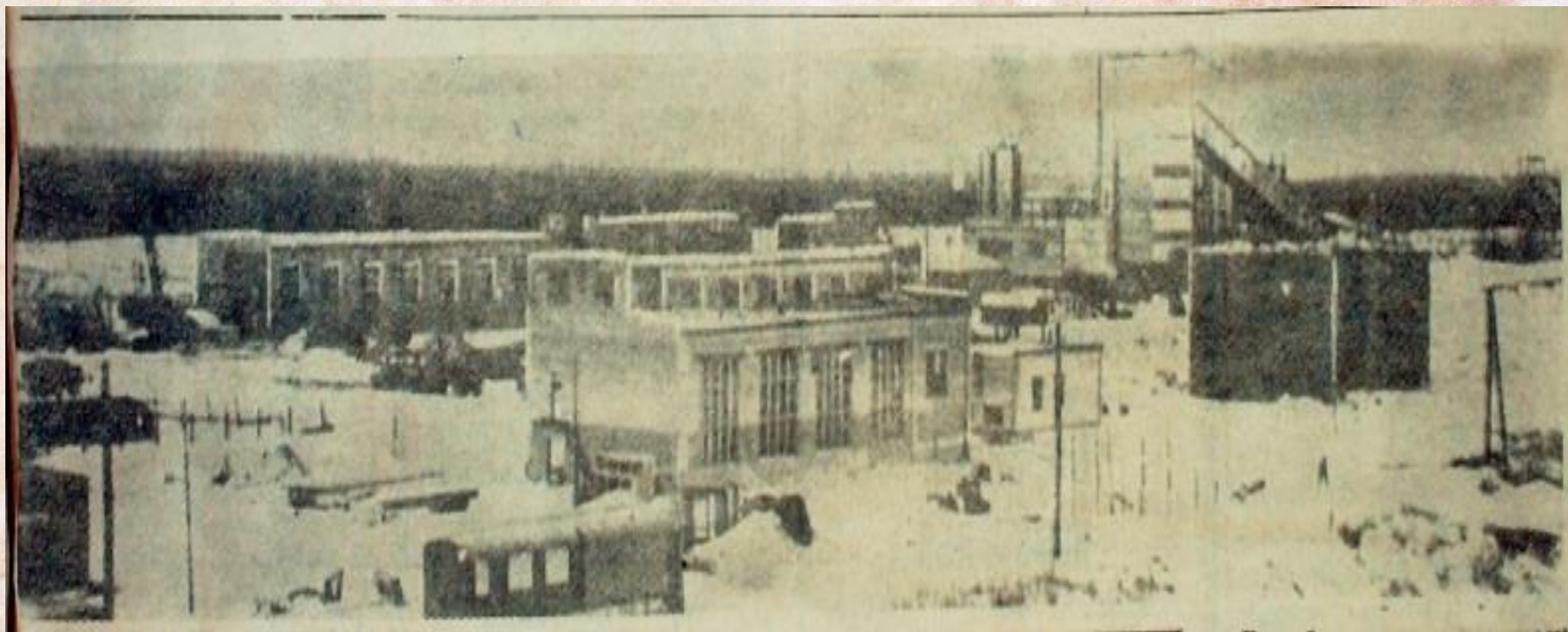
Строительная площадка Константиновского гидроузла.
