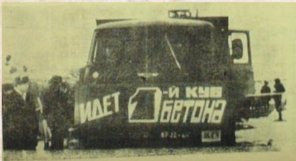
Автомашина МАЗ водителя С.А. Рыжкина на подвозе первого бетона.
